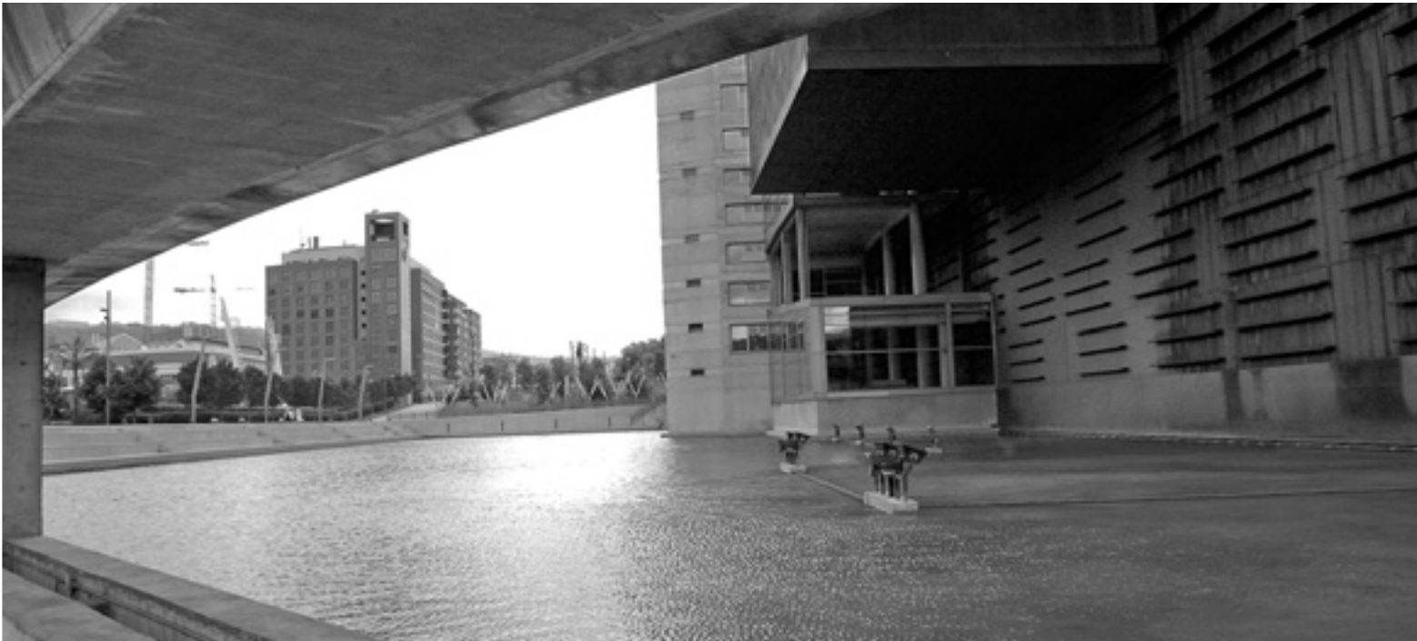
Con la ampliación se perderá una parte del estanque que flanquea el lado que mira hacia la ría de Bilbao. FOTO: ZIGOR ALKORTA
